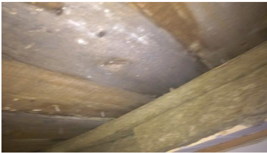
Loftun á þaki efri hæðar er ónóg, sem leiðir til rakauppsöfnunar og myglu.
