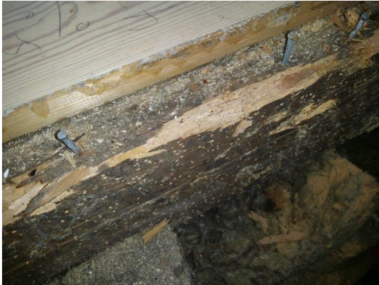
Burðarviðir hússins eru illa farnir eftir veggjatítlur.
